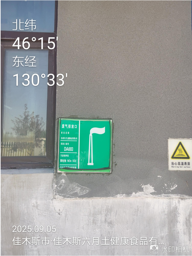
备用燃气锅炉废气排放口标识
