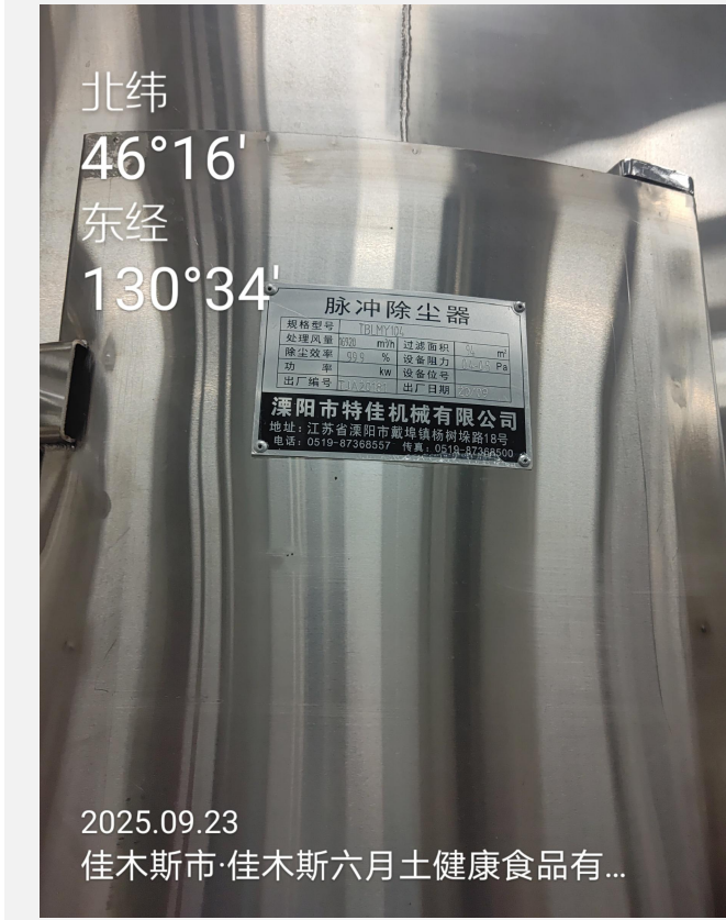
生产车间脉冲布袋除尘器
