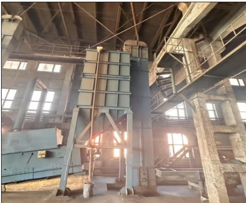
图 6-2-7 本工程布袋除尘器实际样式示意图
