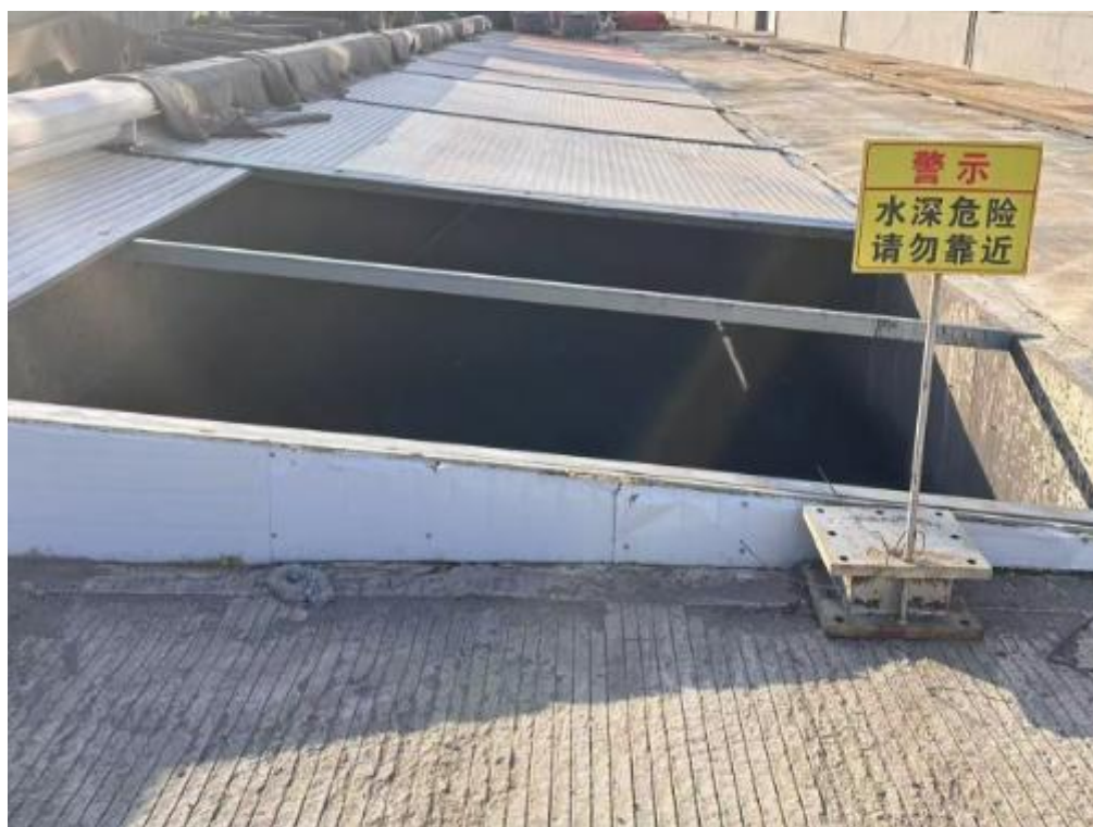
图 6-2-13 本工程混凝沉淀池实际样式示意图
