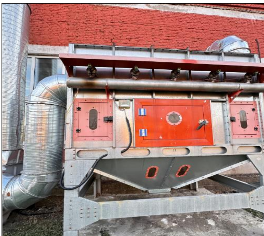
图 6-2-11 本工程滤筒除尘器实际样式示意图
